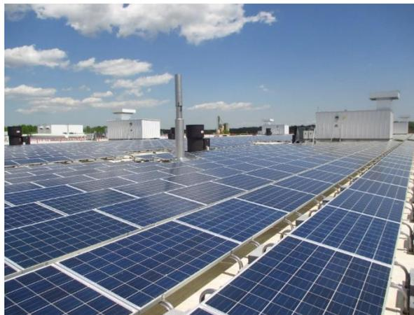
*Imagen 7: Panel solar de 580 kilovatios en la azotea del edificio E-Motor de Operaciones Baltimore.*
