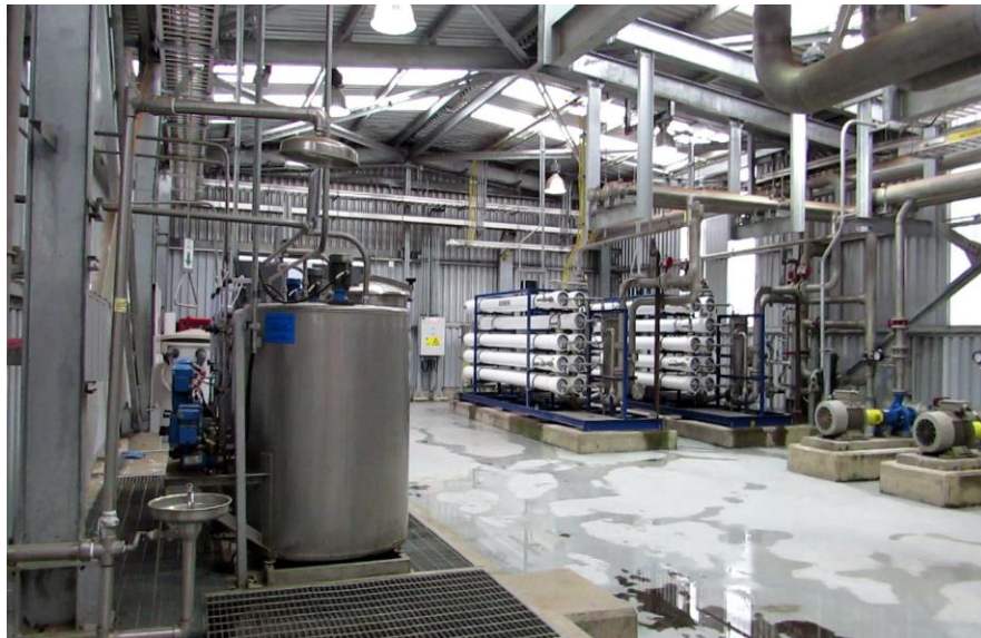
Figura 12- 10: Planta tratamiento de agua, osmosis inversa doble paso
