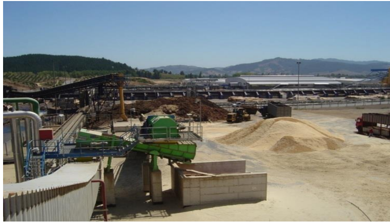
Figura 12-2: Vista patio de biomasa
