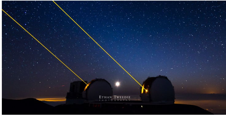
Figura 2.13: Fotografía del observatorio W.M.Keck (Mauna Kea, Hawaii), usando estrellas guía láser. Fuente: Ethan Tweedie Photography ( http://www.ethantweedie.com/ ), “Observatory Photography”.
