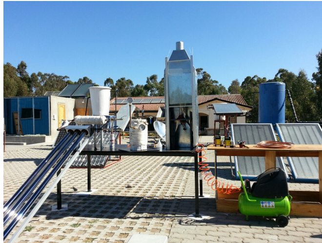
Figura 3.19: Sistema en etapa implementación
