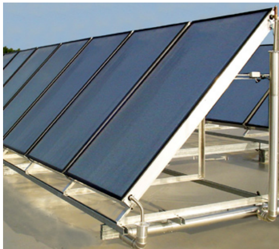
Figura 2.5: Colector de placa plana
