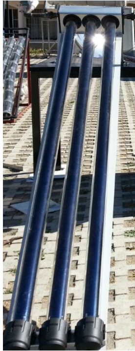
Figura 3.5: Colector solar de tubos al vacío con sistema heat pipe
