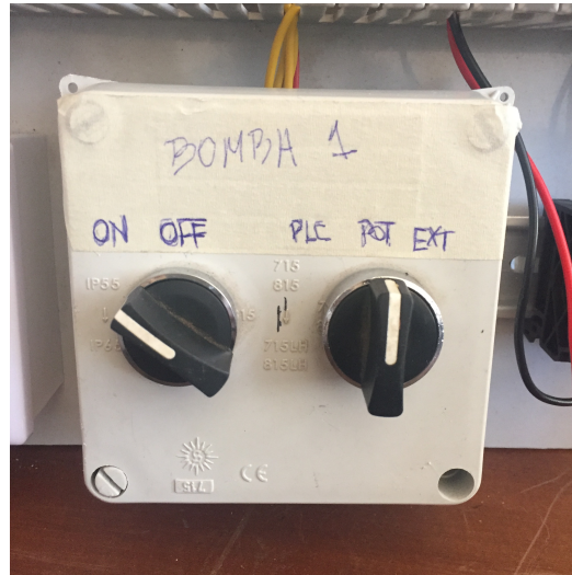
Fig. 1.16: Selector de actuador eléctrico.
