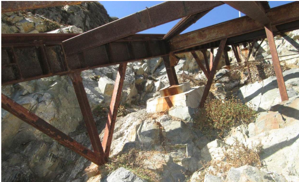
Figura 46: Refuerzos instalados en el año 2005 por Propuerto.
