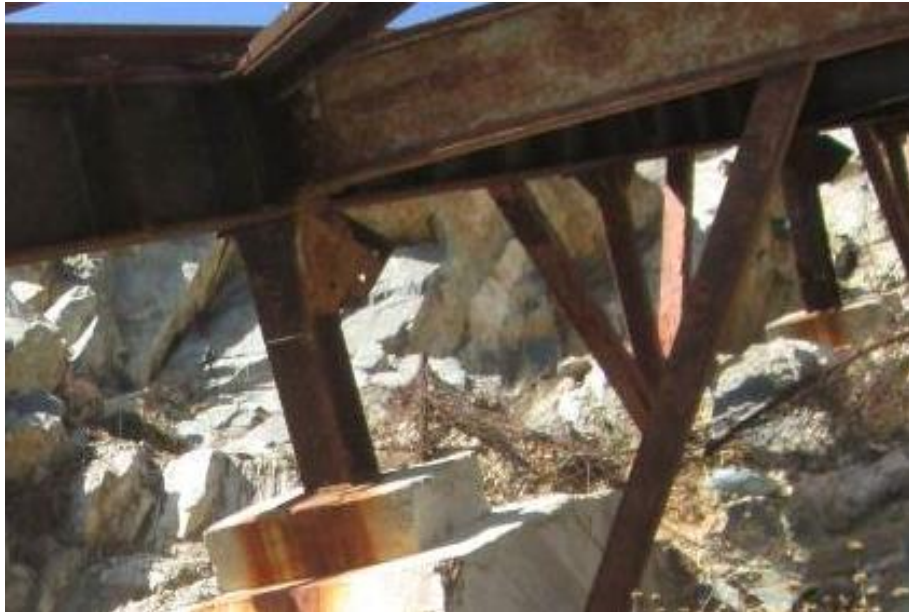
Figura 42: Refuerzos instalados en el año 2005 por Propuerto.
