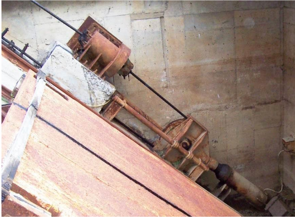
Figura 26: Dispositivo anti-deriva.
