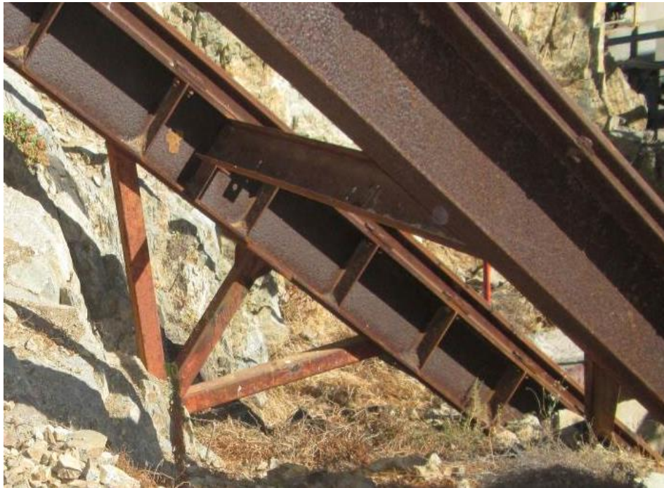
Figura 45: Refuerzos instalados en el año 2005 por Propuerto.
