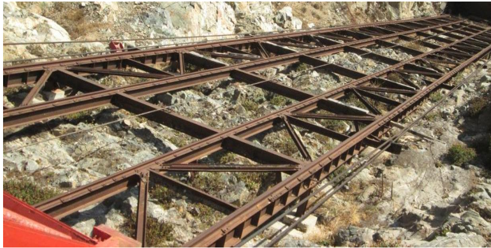
Figura 40: Plano de rodadura tomado desde la estructura superior, se observan los 12 módulos.
