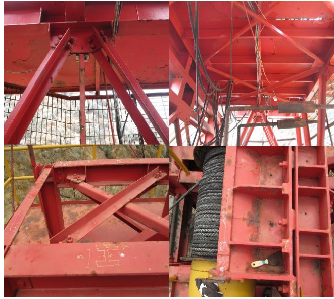
Figura 59: Estado estación superior.
