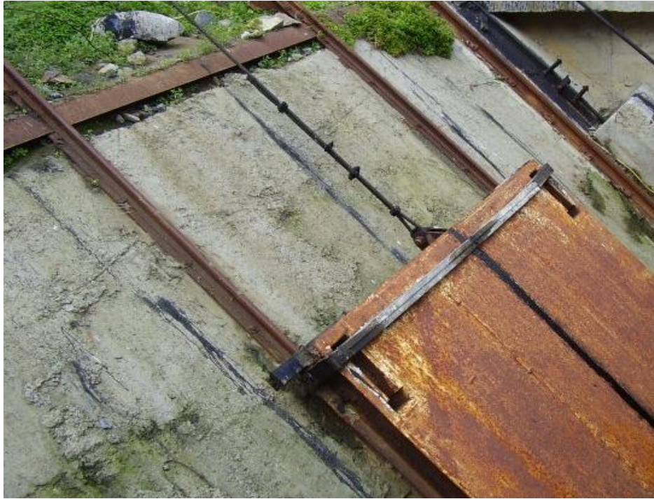
Figura 28: Foto general de contrapeso en estado actual.
