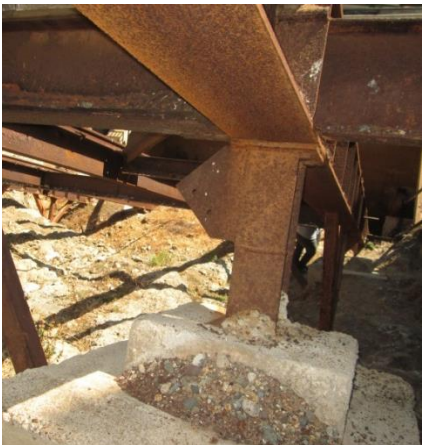
Figura 44: Detalle de Patas Standard Lado Norte.
