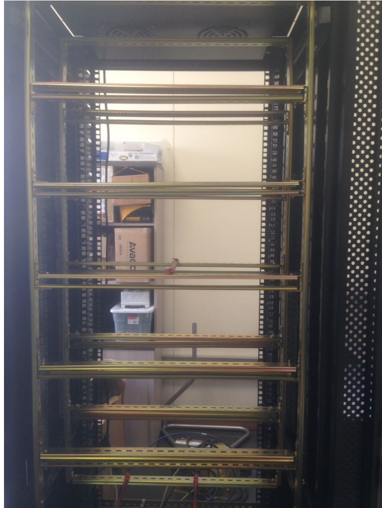
Figura 6.3: Soporte construido para rack
