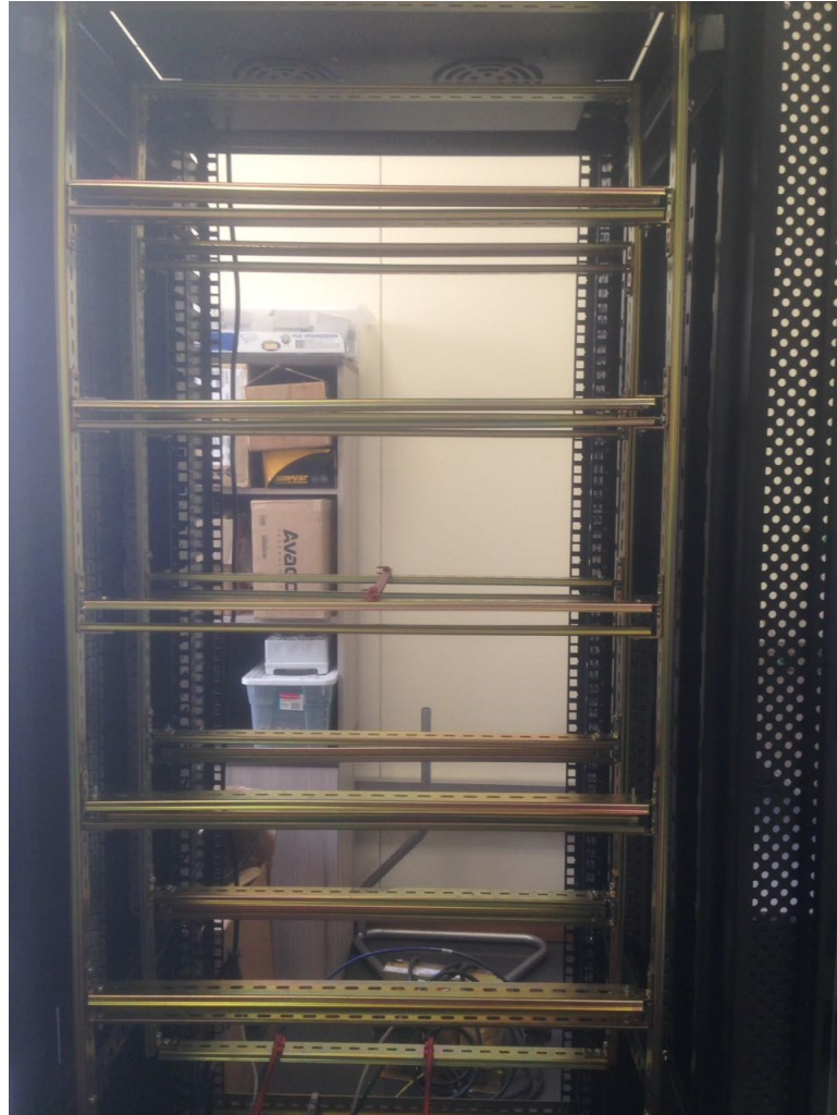
Figura 6.3: Soporte construido para rack
