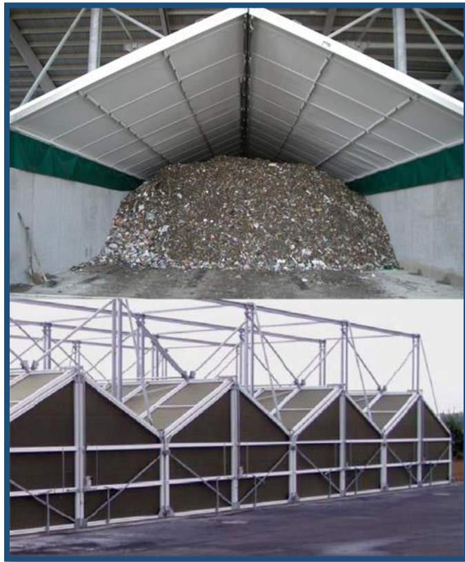
Ilustración 25: Túneles de compostaje con membrana semipermeable. [15]. ( http://www.leblan.com/residuo_urbano.php )
