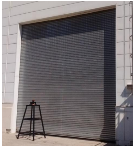
Figura 41: Puerta metálica bahía simulador A320-1.
