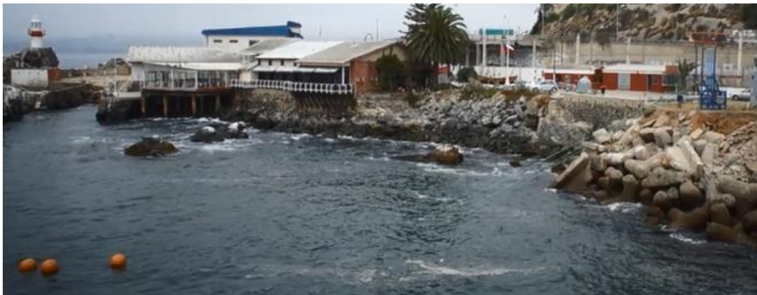
Figura 4.10 Fotografía de la instalación
