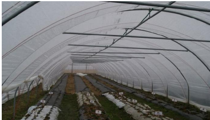
Fig. 2.6. Interior de invernadero tipo Haygrove.
